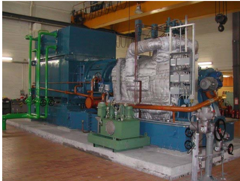
Obr. č. 4 Názorný obrázok parnej turbíny
